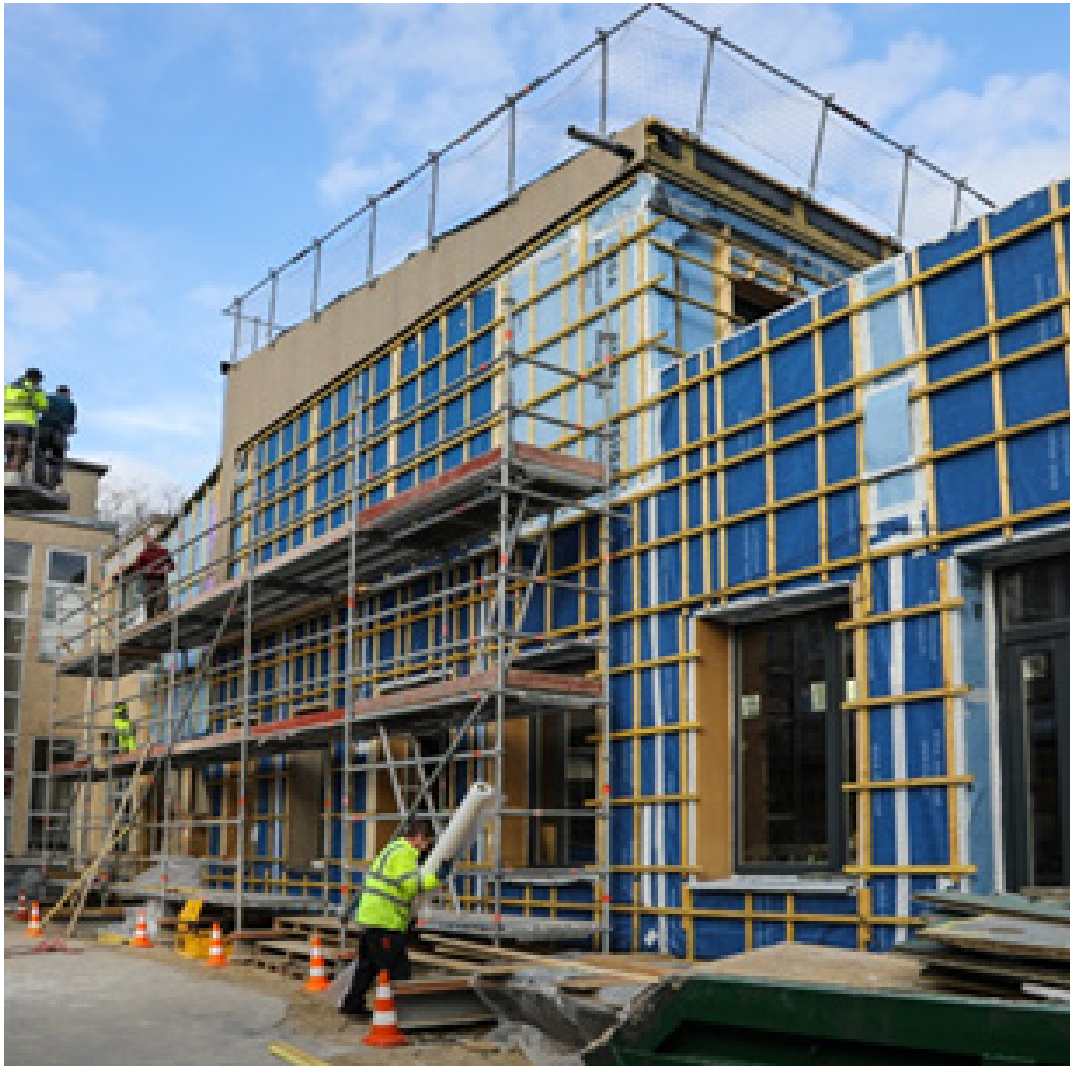
Chantier d'extension de l'école Ivry-Levassor (Paris 13e) à base de matériaux biosourcés et de réemploi Architecte : La Petite Fabrique de la Ville de Paris Entreprise : Le Chênelet
