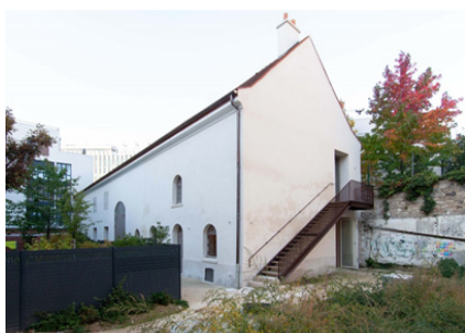
Rénovation Ferme Montsouris (Paris 14 e ) Architecte : GRAND HUIT - Entreprise : BOYER
