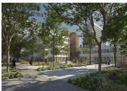
Création d'une Médiathèque James Baldwin et de la Maison des Réfugiés (Paris 19 e ) Architecte : Atelier Philippe Madec Architecture Entreprises : CBC et CENOMANE
