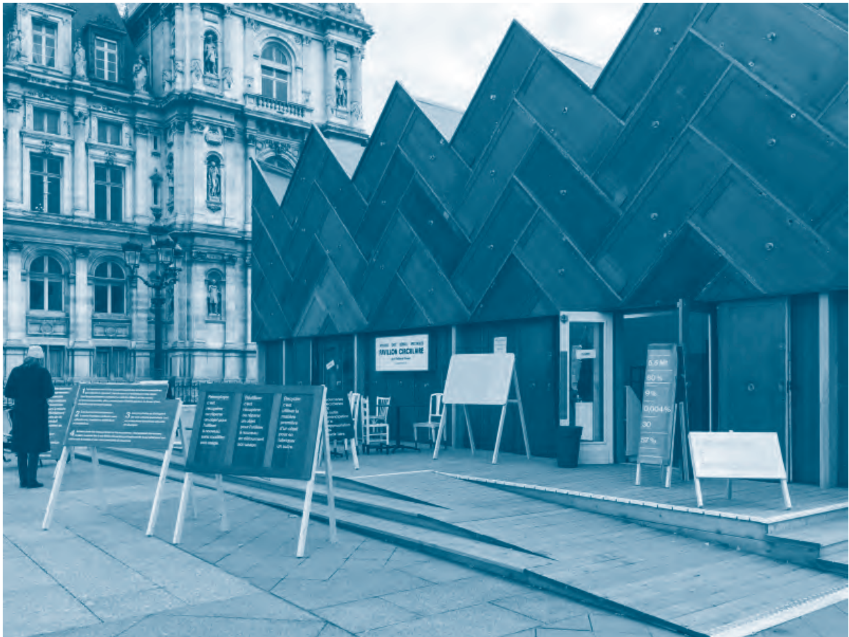
Pavillon circulaire, parvis de l'Hôtel de Ville, Paris 4, Encore Heureux architectes, 2016
