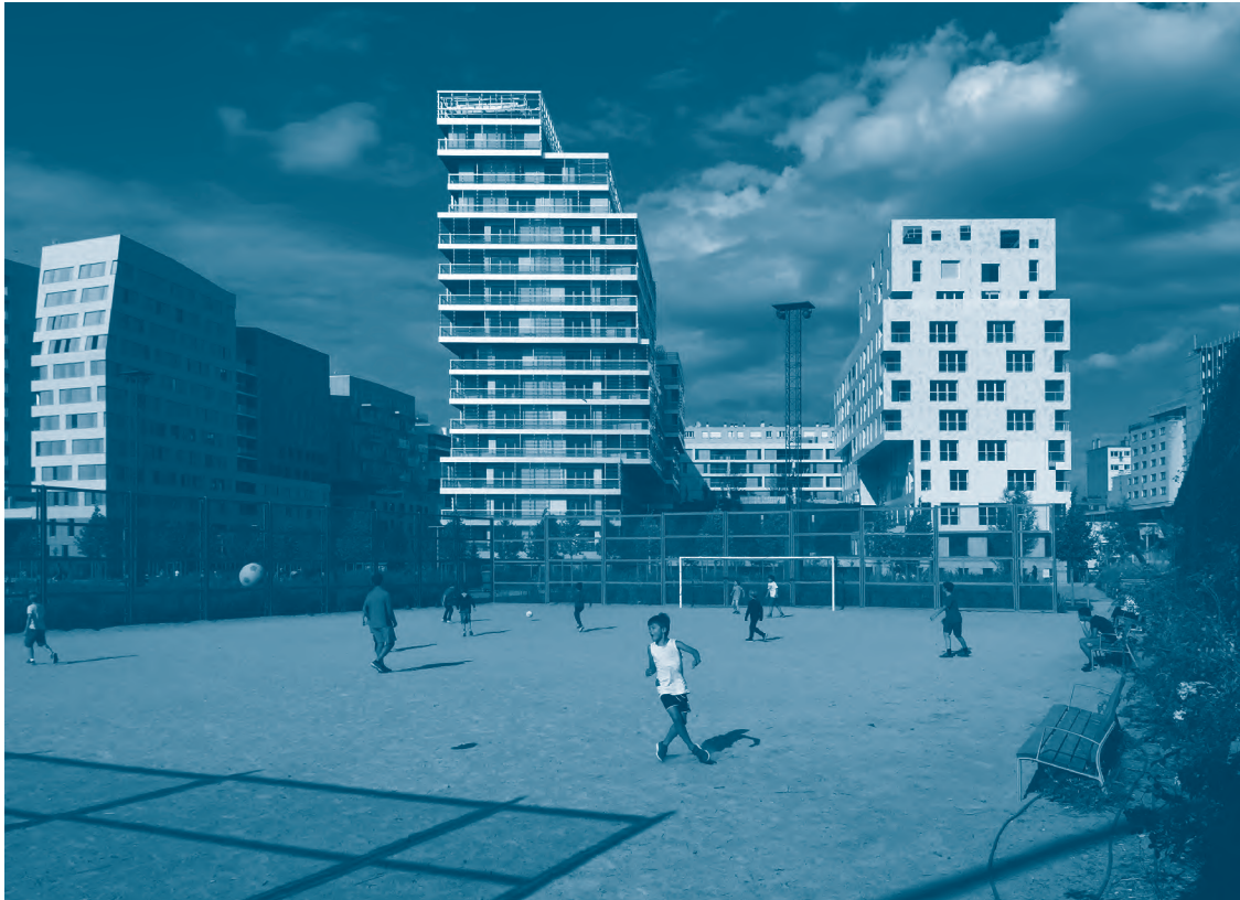
Immeubles de logement © GausaRaveau, AvenierCornejo
