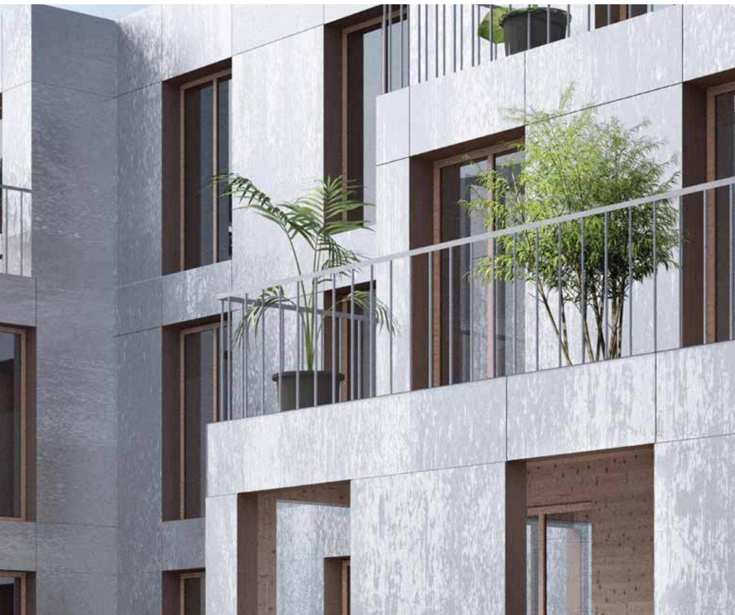
circulations verticales, et par conséquent le positionnement des appartements, ainsi que la forme urbaine résultante de l'immeuble. L'ossature simple et rationnelle en béton armé est complétée par un remplissage de façade réalisé avec des éléments de grande dimension en bois. Le choix du bois est doublement stratégique : il allège la construction, et diminue par conséquent les problèmes coûteux liés à la superposition des structures, tout en améliorant l'impact écologique du projet.
