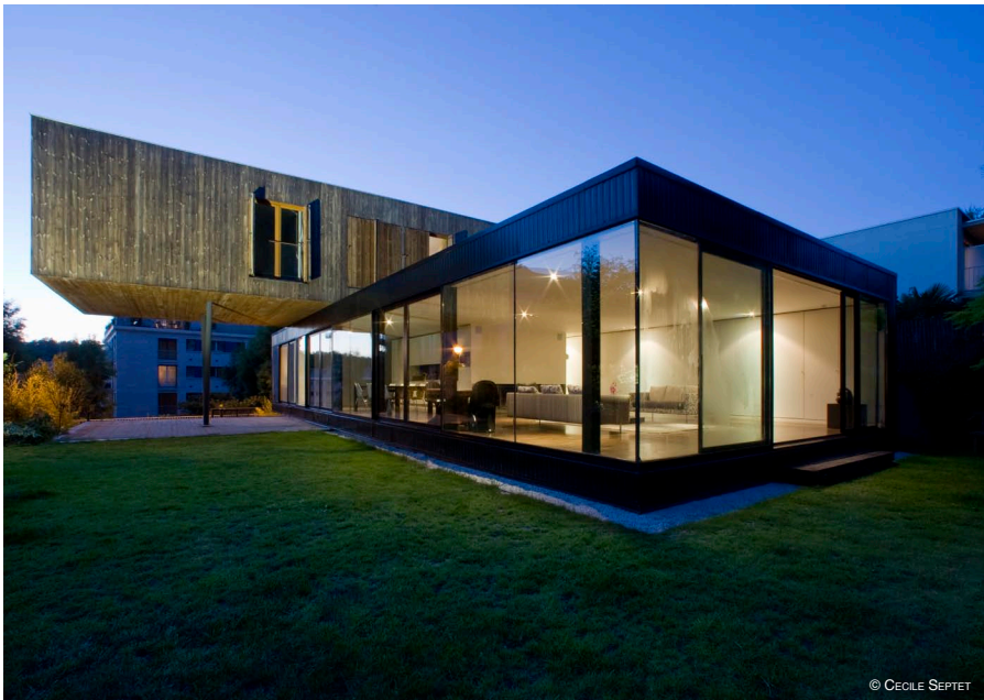
MAISON R 2009 / 92310 Sèvres MAÎTRISE D'OEUVRE : Colboc Franzen & Associés MAÎTRISE D'OUVRAGE : Privée
