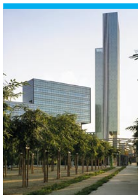
2008 HÔTEL ME BARCELONA, BARCELONE, ESPAGNE, DIAGONAL DEL MAR DOMINIQUE PERRAULT ARCHITECTURE Maître d'ouvrage : Hoteles Sol-Melia Palma de Mallorca © André Morin / DPAI ADAGP
