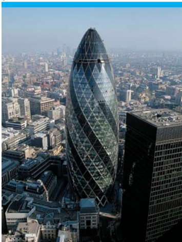
2004 SWISS RE, LONDRES, ROYAUME-UNI FOSTER + PARTNERS arch. Maître d'ouvrage : Swiss Re © Nigel Young
