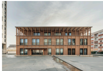
Transformation du Pavillon Keller en équipement d'enseignement supérieur et espaces de logistique urbaine, Paris 15 e , Nunc architectes, réhabilitation et surélévation, BTA Architecture, logistique urbaine, La Poste Immobilier, maîtrise d'ouvrage, 2025. Édifice d'origine : Albert Grégoire, architecte, 1970. Photographie © Luc Boegly / © Nunc architectes.
