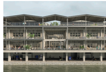
Les Amarres, hôtel logistique et social, Paris 13 e , Encore Heureux Architectes, AREP, BE généraliste, Fludis, logistique urbaine et fluviale, Yes We Camp, accueil du public, Aurore, accueil de jour, maîtrise d'usage, Sogaris, Haropa Port, maîtrise d'ouvrage, en cours. Perspective © Metrochrome.
