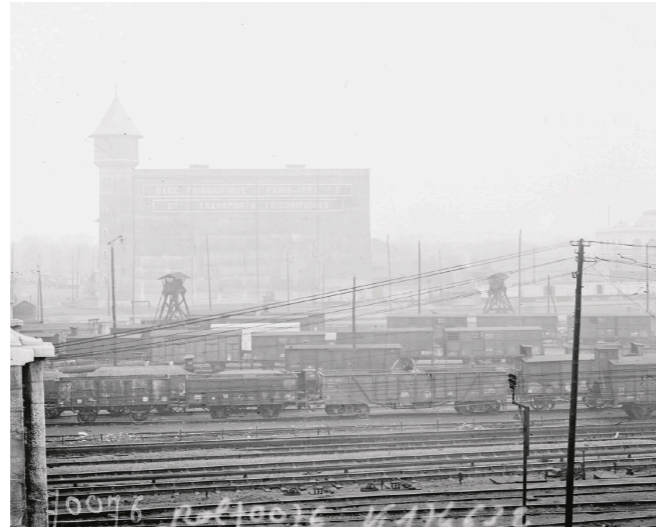
Gare frigorifique de Paris-Ivry, Paris 13 e , Compagnie du chemin de fer de Paris-Orléans, maîtrise d'ouvrage, 1921. Photographie de l'Agence Rol, 1921. © BnF
