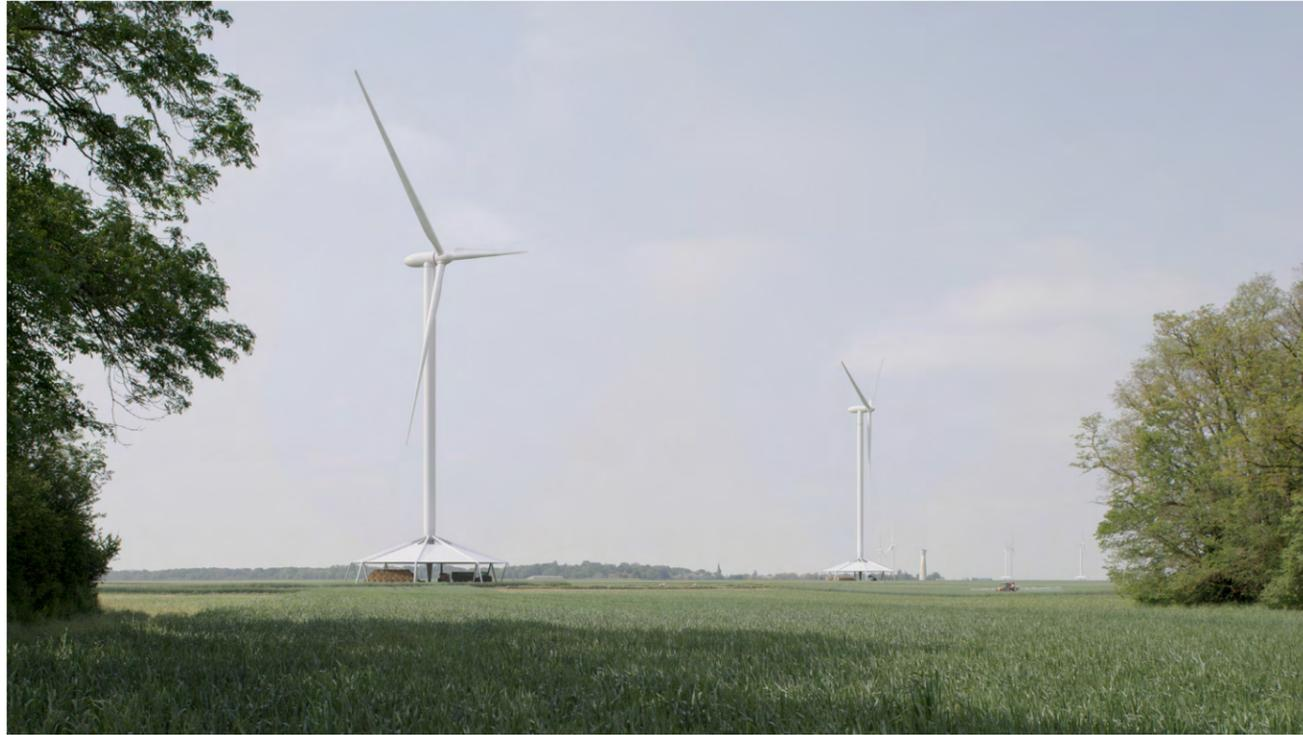
C'est le printemps dans la Beauce, il fait 16 °C. À 10 mètres au-dessus du sol, le vent souffle à plus de 30 km/h; à 100 mètres, sa vitesse atteint 42 km/h, propulsant l'hélice de chacune des éoliennes, qui « moissonne » l'énergie du vent à travers un disque de plus de 6 000 m<sup>2</sup> et génère une puissance proche de 1 000 W/m<sup>2</sup>. Chaque éolienne fournit 3 MW de puissance électrique et possède un rendement de conversion de près de 50 %.
