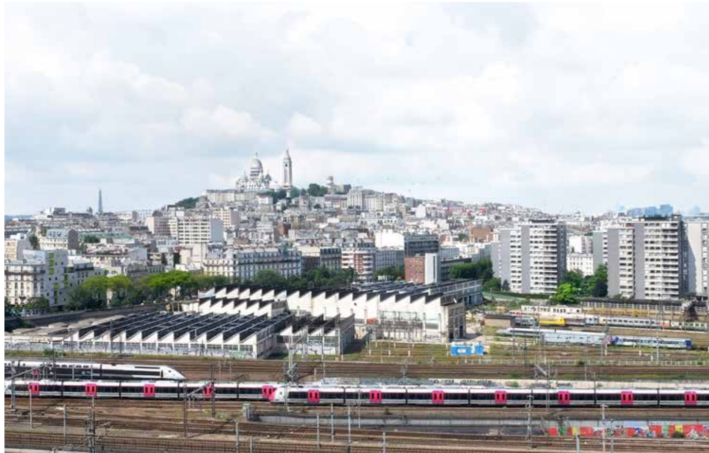
Le site Jardin des Mécanos est délimité au sud par la rue Ordener, à l'ouest par la rue René Clair et par le faisceau de rails de la gare du Nord à l'est. © Jean-Claude N'Diaye
