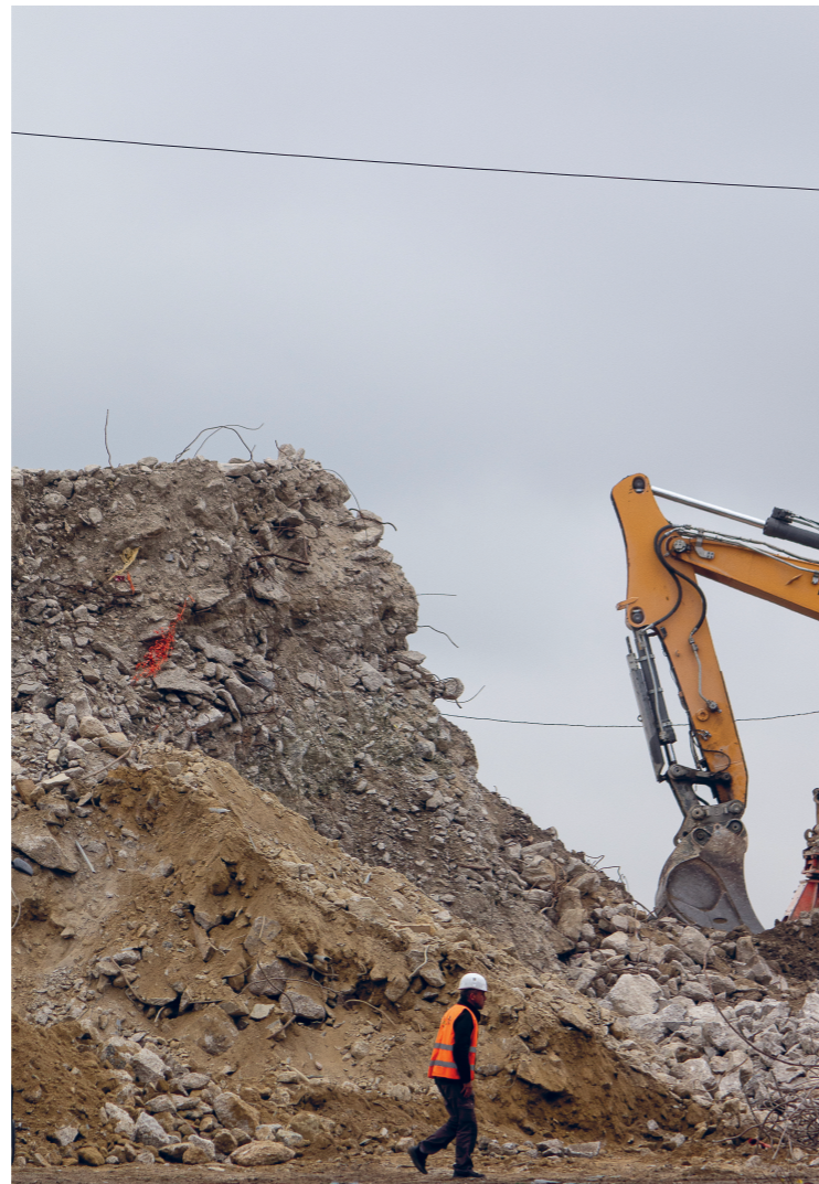
Ressource universelle : Chantier de démolition de l'autoroute A168, dite « la balafre », en vue du prolongement de la ligne 1 du tramway, 46 000 tonnes de béton traitées in situ avant leur recyclage en couche de forme, frange Montreuil-Romainville, décembre 2020.
