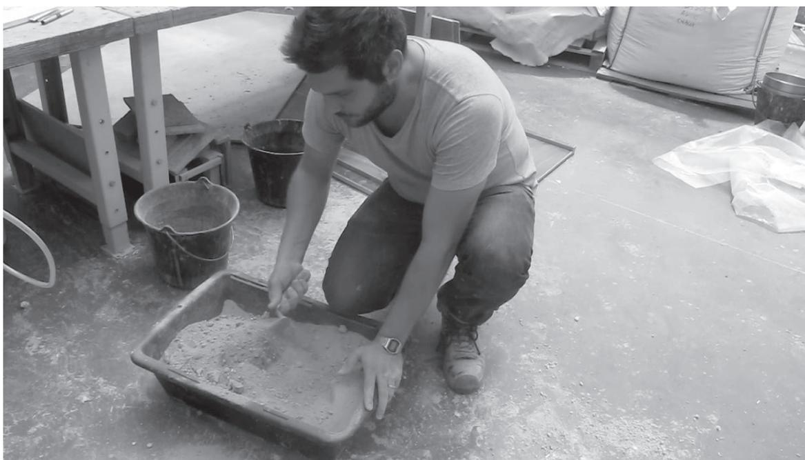
(18) Un premier mélange de terre non chaulée et de poudre d'argile est effectué à sec afin d'optimiser la répartition de l'argile autour des grains. Pour d'autres techniques comme les enduits, le mélange par voie humide ou en barbotine est préférable.
