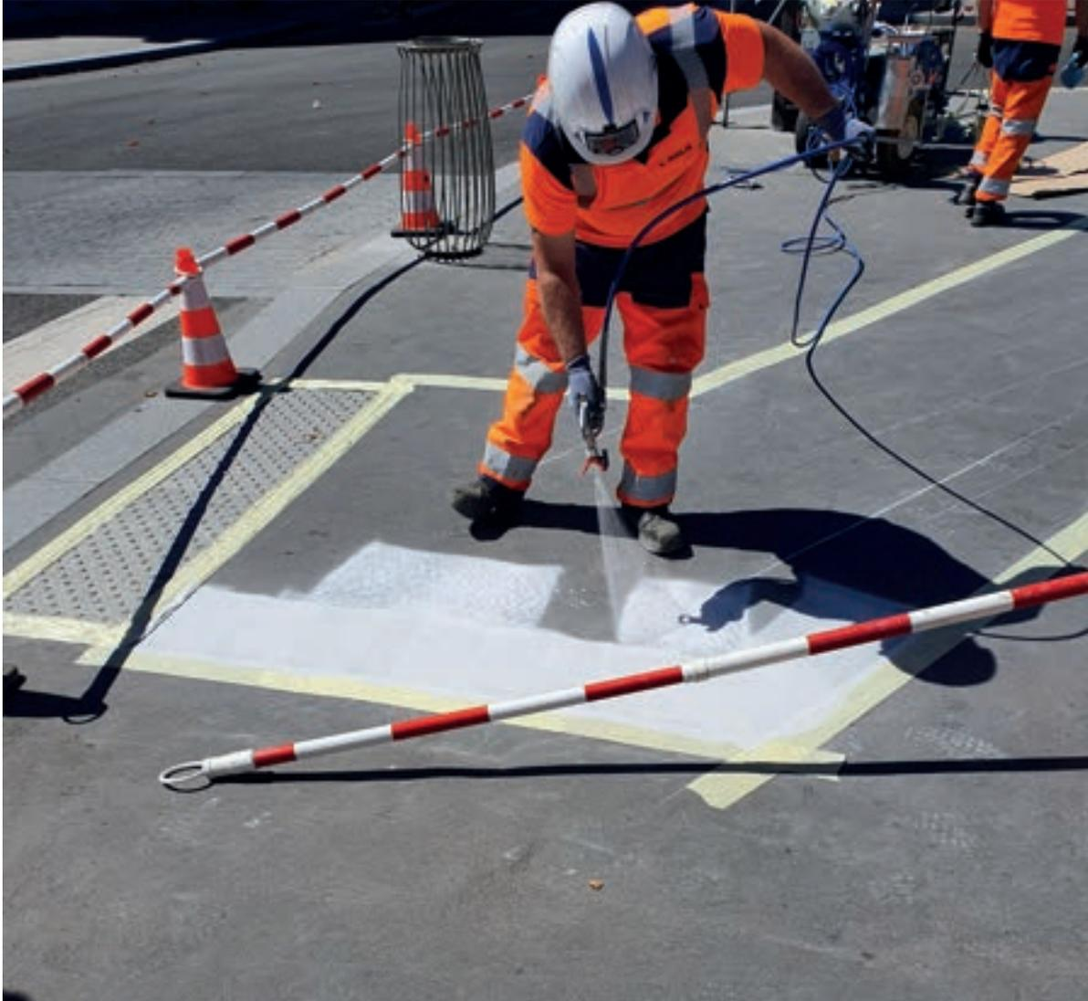
Expérimentation d'un revêtement de sol infrarouge pour abaisser la température du bitume, ville de Paris.
