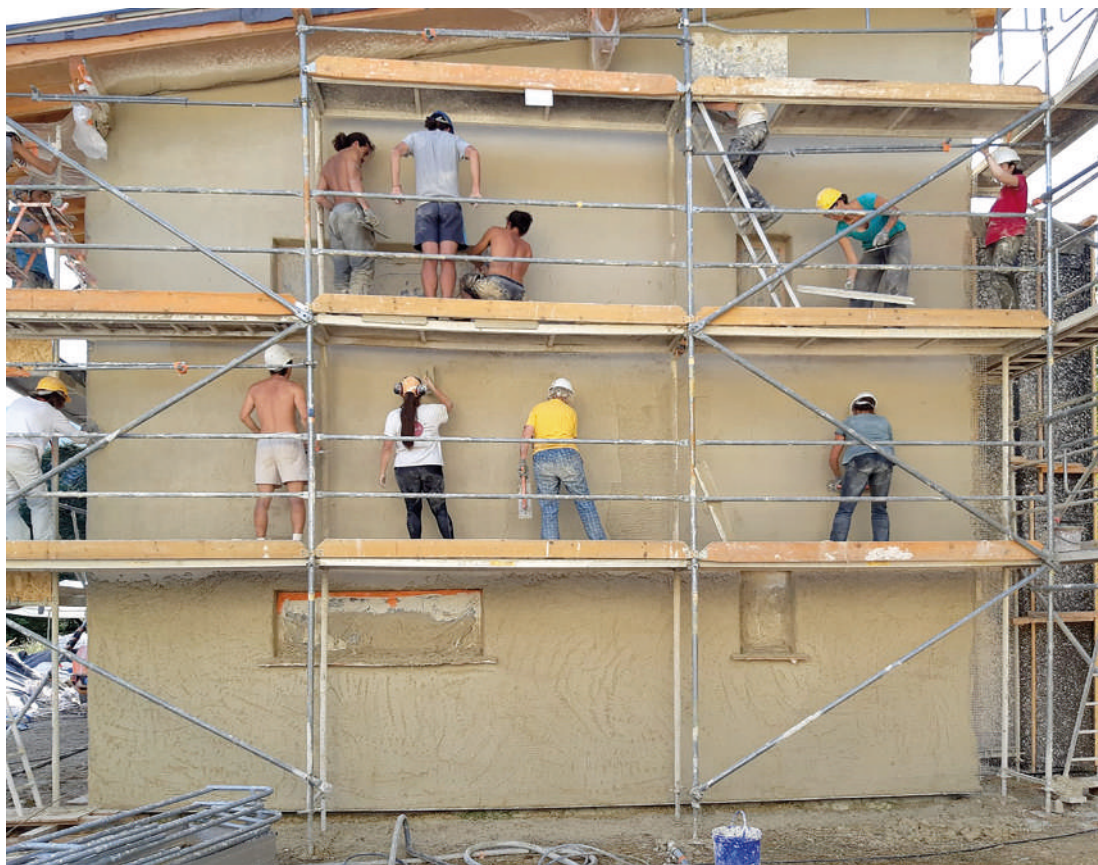
Autoconstruction et matériaux bio et géo-sourcés dont poteau-poutre bois avec caissons isolants en paille, enduits terre
