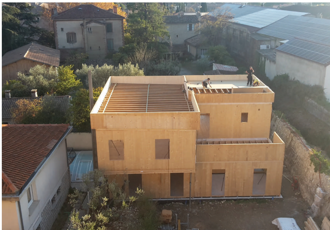
Structure en bois CLT, isolation fibre de bois, bardage bois
