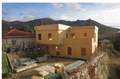
Structure en bois CLT, isolation fibre de bois, bardage bois
