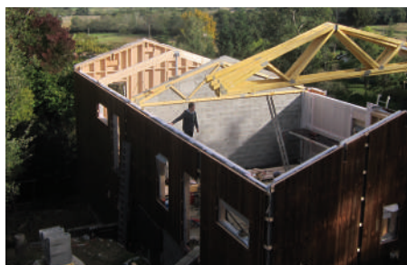
Structure et charpente en bois, isolation ouate de cellulose, doublages en fibre de bois, enduits intérieurs en terre, bardage bois
