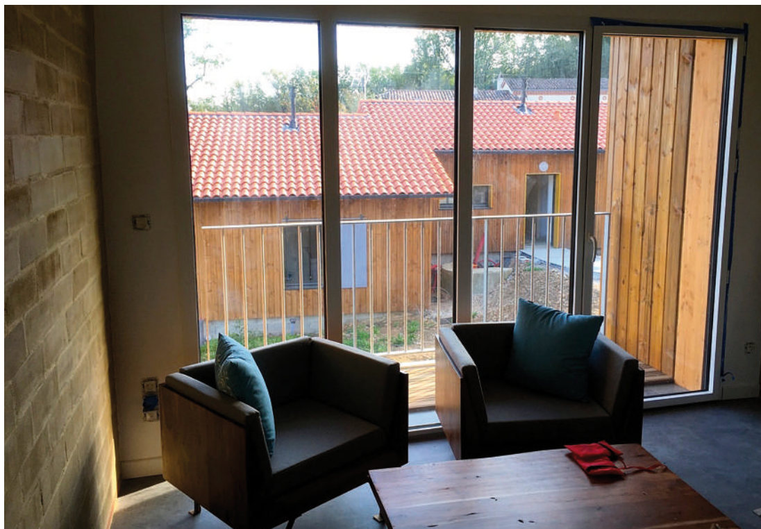
Structure et charpente en bois, isolation ouate de cellulose, doublages en fibre de bois, enduits intérieurs en terre, bardage bois
