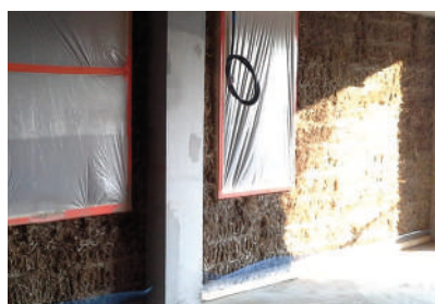
Murs à ossature bois isolés en paille, enduits en terre crue, panneaux en fibre de cellulose
