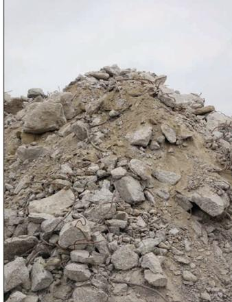
**Concrassage.** Après le retrait des gros fers, concrassage et criblage sur site des gravats de béton en gravats de 0/60 mm, chantier de prolongement de la ligne 1 du tramway, frange Montreuil-Romainville, décembre 2020.
