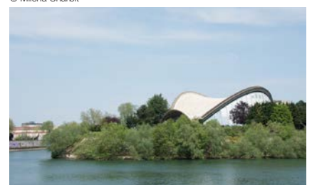
12 - Île Saint-Denis. Stade couvert de Saint-Ouen, Anatole Kopp et Pierre Chazanoff, architectes, René Sarger, ingénieur, 1965-1971. © Pierre L'Excellent, 2016
