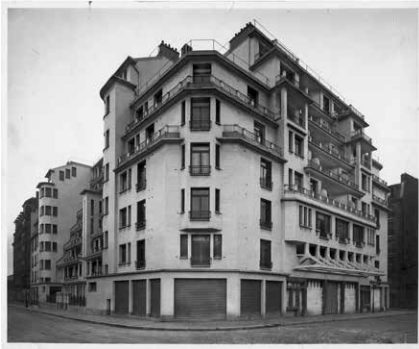
1922-1926, 79 logements, 75018 Henri Sauvage, architecte © SIAF/Cité de l'architecture et du patrimoine/ Archives d'architecture du XXe siècle
