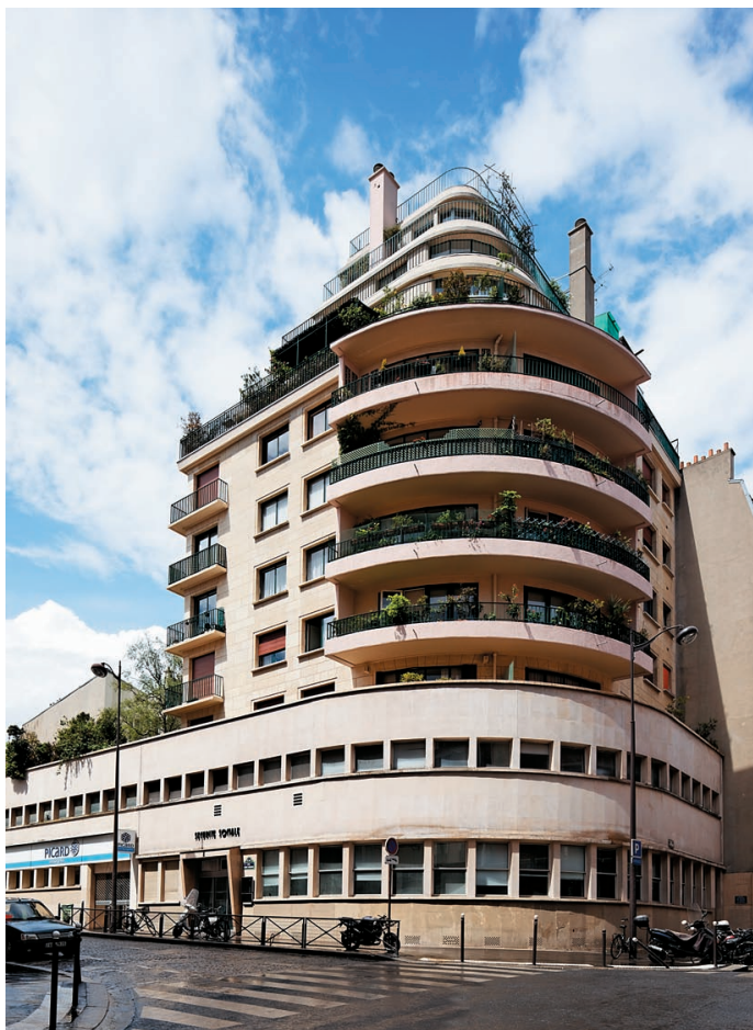
Jacques Bargiarelli, immeuble de logements, 33-37, rue Lacépède, 37, rue Gracieuse et 2-4, rue Saint-Médard, 5e, 1955-1959 : commerces et bureaux occupent le socle. © Vincent Fillon
