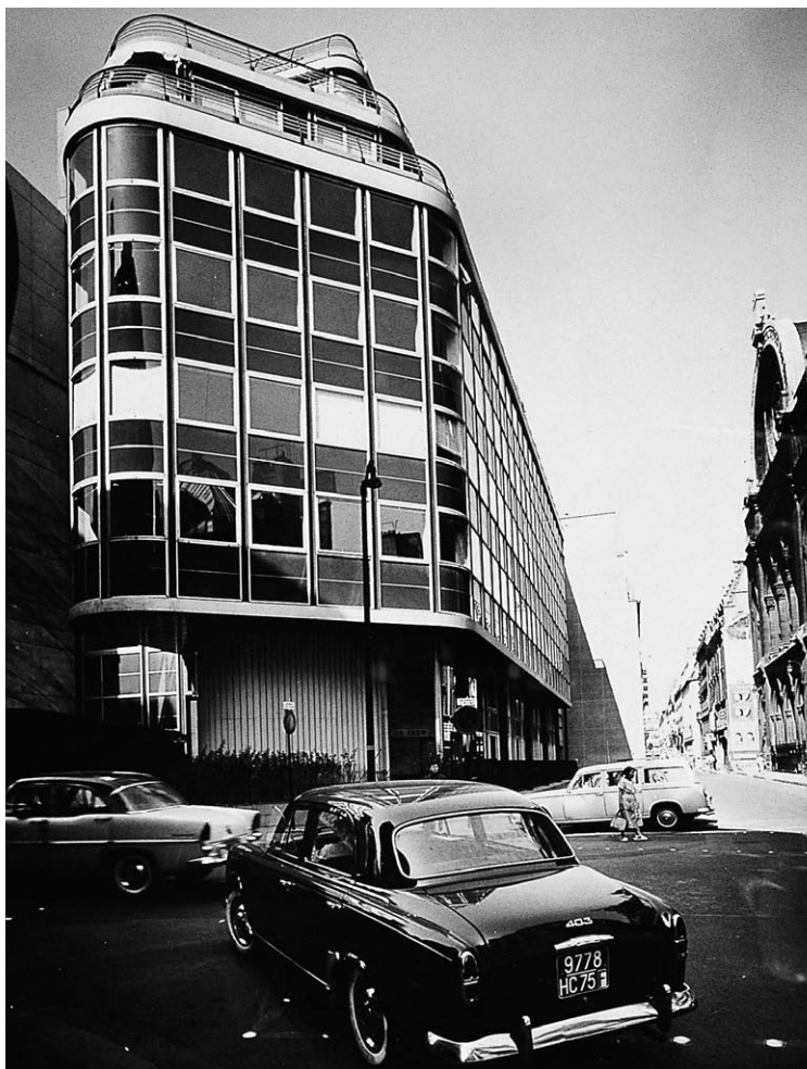
Jean Balladur et Benjamin Lebeigle, immeuble de bureaux, 37, rue de la Victoire, 2e, 1958 Coll. Pavillon de l'Arsenal/ADAGP 2010
