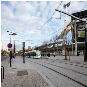
vue après transformation © Vincent Fillon
