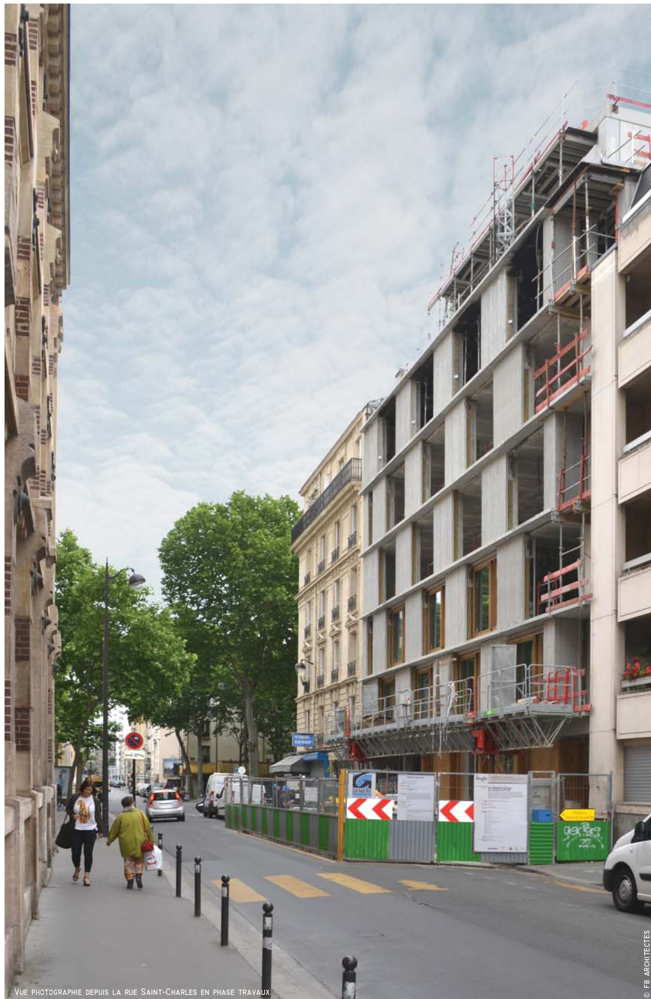
VUE PHOTOGRAPHIE DEPUIS LA RUE SAINT-CHARLES EN PHASE TRAVAUX
