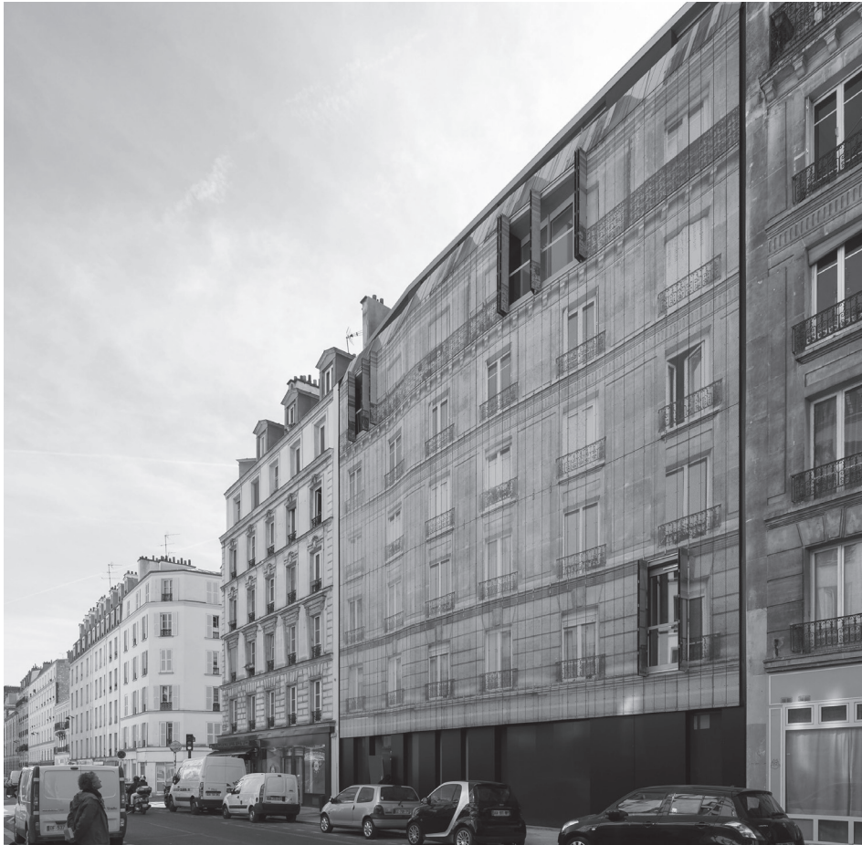
Immeuble de logements rue Championnet © Pierre l'Excellent
