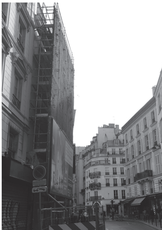
Végétalisation des structures de travaux © Frédéric Leyre, Clément Carrière et Nicolas Didier
