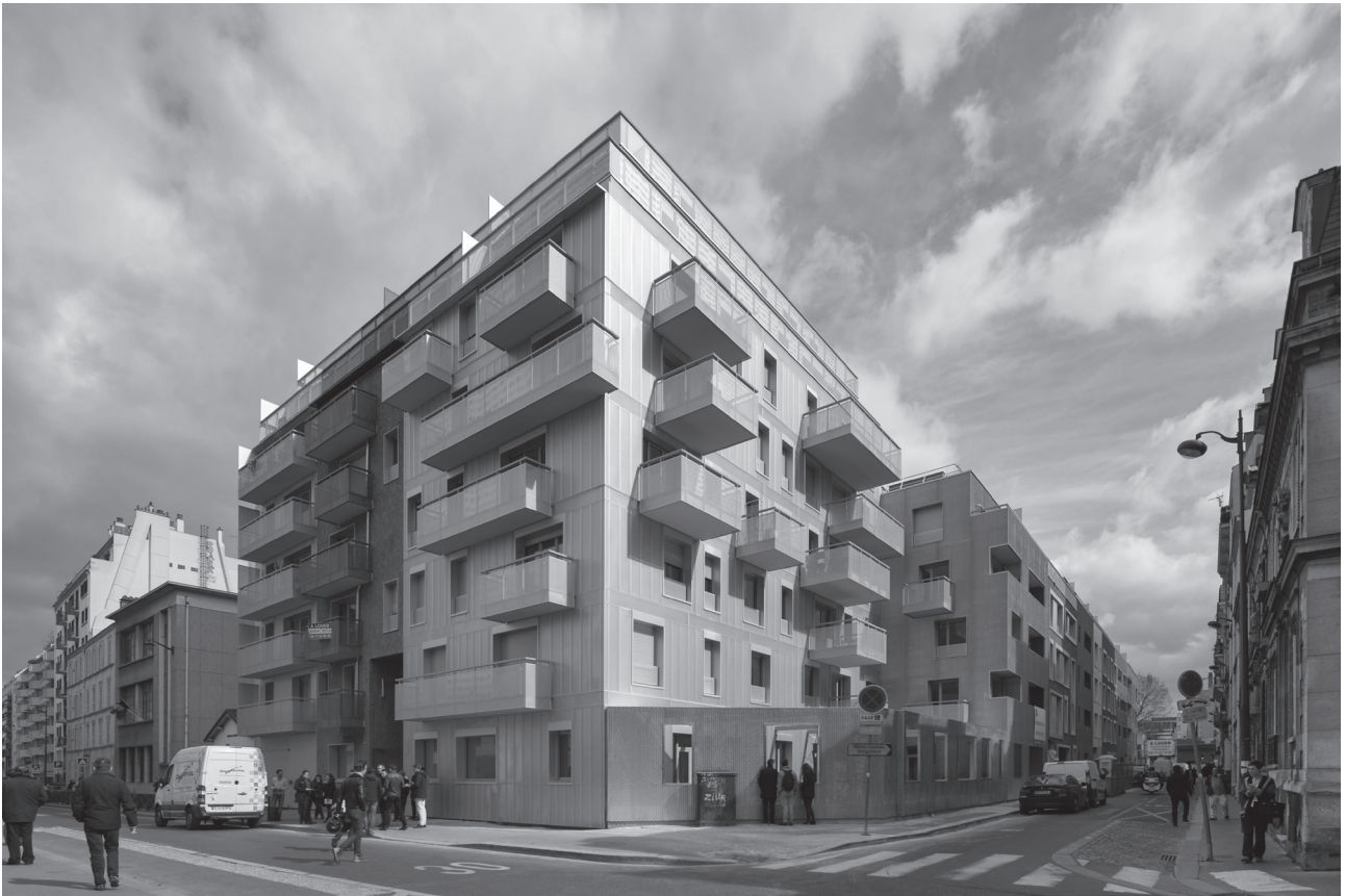
3 immeubles de logements © Pierre l'Excellent
